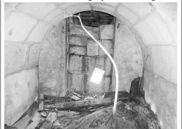
Cripta do século XVIII com pelo menos dez sepulturas, descoberta durante as obras na Igreja dos Clérigos, onde se julga estar o arquiteto Nicolau Nasoni, no Porto. O arquiteto italiano foi quem, há mais de 200 anos, projetou o templo e a torre anexa, de 76 metros de altura e uma escada em espiral com 240 degraus, que é considerada o 'ex-libris' da cidade do Porto.
